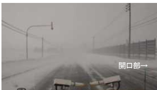
写真-1 防雪柵の開口部における吹雪時の状況の例 2)
