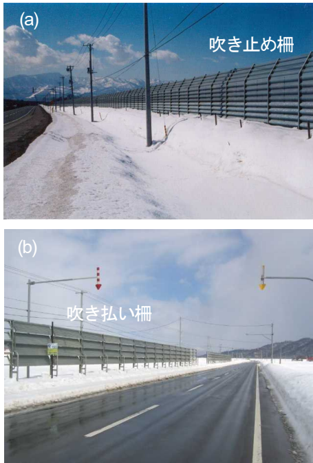
写真-2 防雪柵の例 1) (a) 吹き止め柵、(b) 吹き払い柵。
