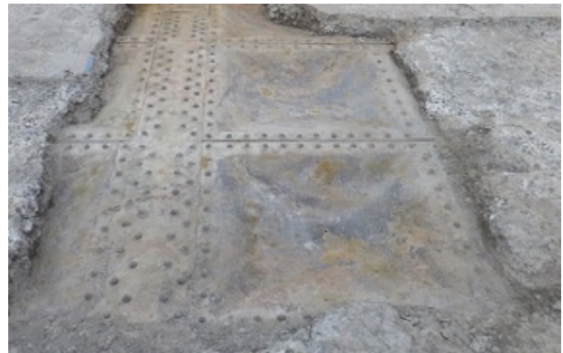
写真-11 バックルプレート上面
