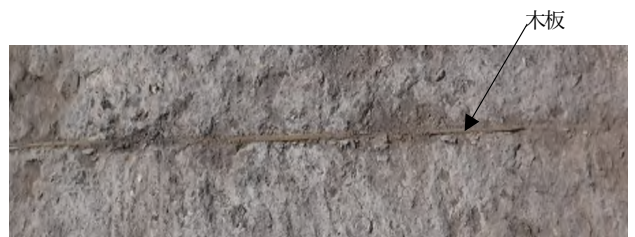
写真-7 横桁部 (木板部)
