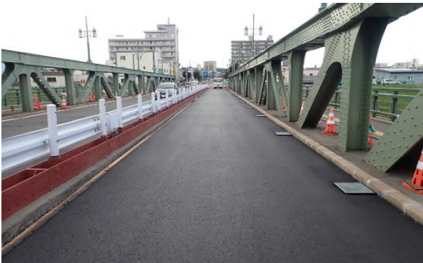
写真-14 舗装新設後の路面（基層）
