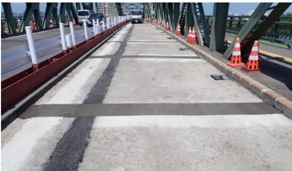
写真-13 コンクリート打設後の床版面
