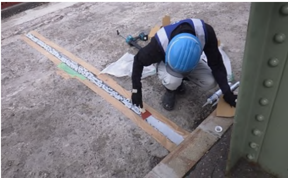
写真-12 横桁部のシーリング材設置状況
