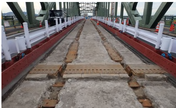
写真-9 路面電車跡（鋼製の枕木）
