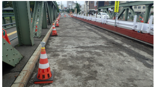
写真-6 床版面の状況
