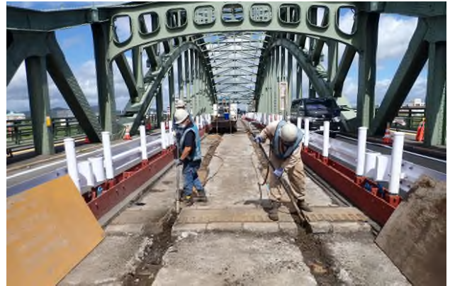
写真-10 アスファルト除去状況(路面電車跡)
