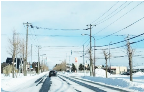
写真-5 通信線の直下で主幹を強剪定された街路樹 (写真右) と剪定されていない街路樹 (左側) 通信線直下で切り詰め剪定をすると毎年剪定が必要になる
