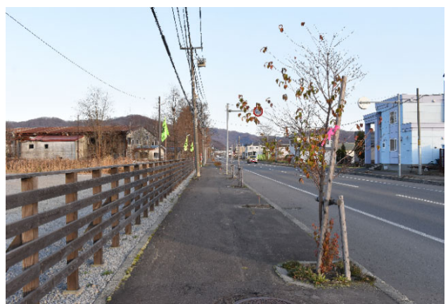
写真-10 民地側に電柱を配置した事例。道路端側の街路樹の生育空間が確保されている。また樹木が成木となった時に緑陰により電柱や電線が隠れるため道路側からの景観の評価も向上する
