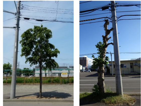
写真-2 植樹帯の直近に電柱が設置された例。高木が成木になった際の樹高や樹冠が想定されておらず、成木になると毎年剪定の必要が生じる。また写真右のように枝を全て取り除く強剪定が行われている事例もよく見られる
