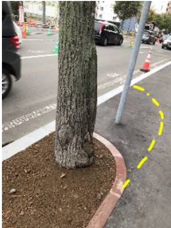
写真-3 植樹帯の直近に占用物の柱が設置されているため植樹帯の拡幅が均等になされなかった例
