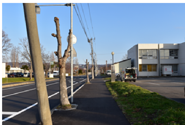
写真-1 低圧線の下部で強剪定された街路樹
