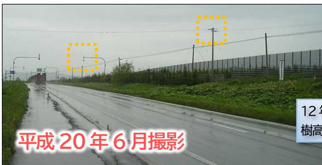
写真-6 平成20年度に山側・西側の全景を撮影
