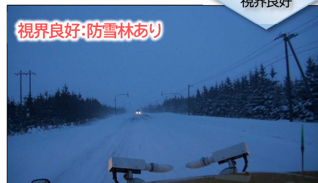
写真-15 写真-13と同時刻の林整備箇所は視界良好
