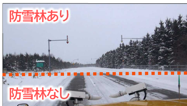
写真-8 防雪林の有無による路面状況の差異(令和3年1月)
