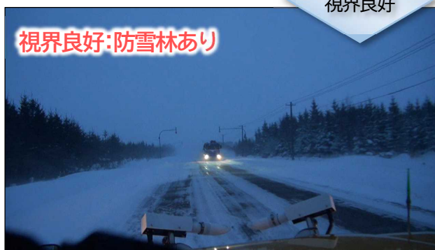
写真-12 写真-10と同時刻の林整備箇所は視界良好
