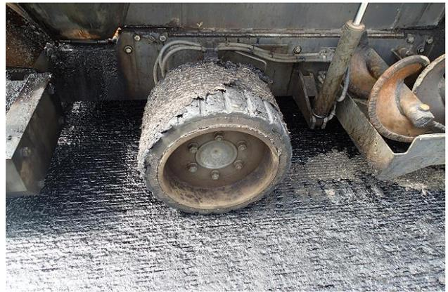
写真-2 タックコートの剥離
