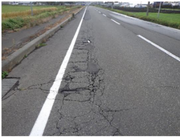
写真-4 調査箇所路面状況
