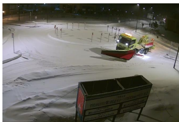
写真-2 ラウンドアバウトの除雪状況 (北海道浜頓別町)
