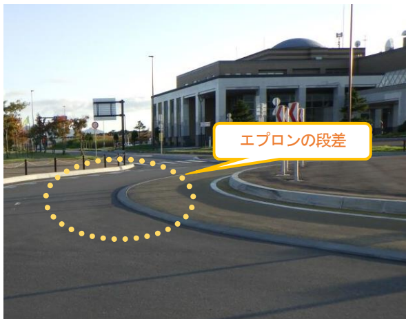
図-3 環道とエプロンの段差 (北海道浜頓別町)
