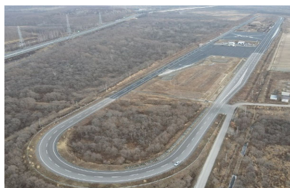
写真-1 苫小牧寒地試験道路
