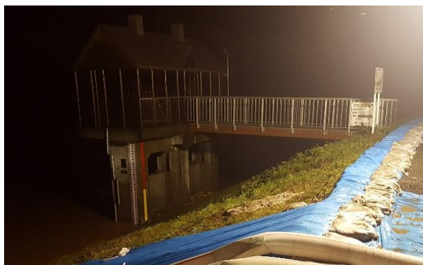
写真-1 夜間の樋門現場状況の例
