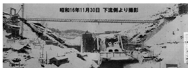
写真-3 雨竜第1ダム工事中全景（北電提供）
