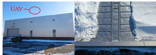
図-12 管理施設の屋根の確認
