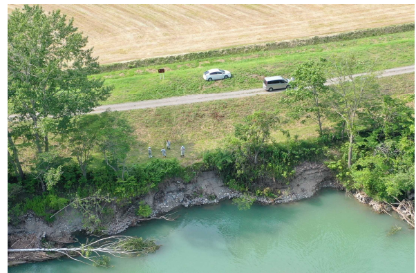
図-11 オーバーハング箇所の確認
