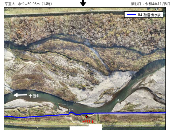
図-10 河岸浸食状況の変遷
