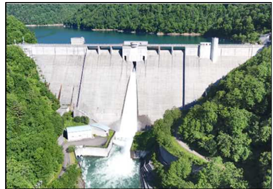
図-4 札内川ダムからのフラッシュ放流状況
