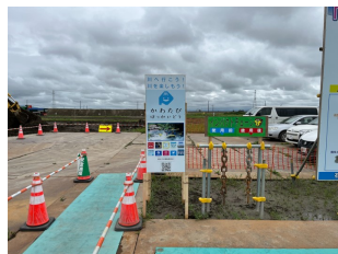
写真9 工事看板 PR 状況
