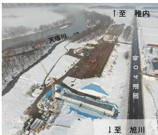
写真-1 施工箇所全景
