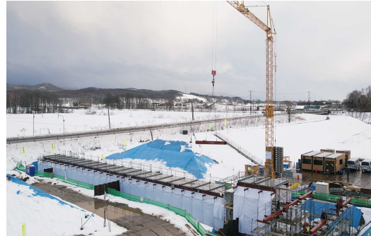
写真-4 定置式水平ジブクレーン施工状況
