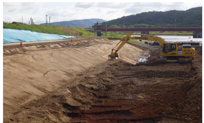
写真-1 河道掘削施工状況（令和3年度）
