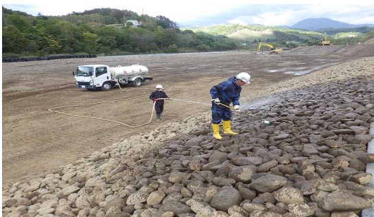
写真-2 寄せ石施工状況（令和4年度）
