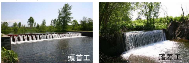
写真-1 魚類の移動の連続性を阻害する河川横断工作物
