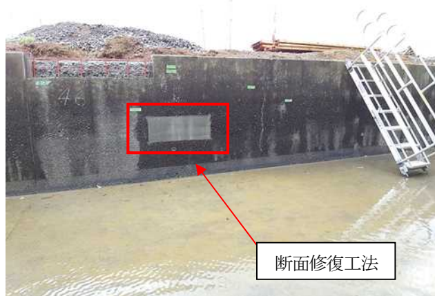
写真-7 断面修復工法
