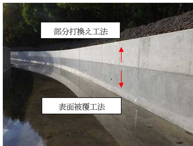
写真-8 表面被覆工法
