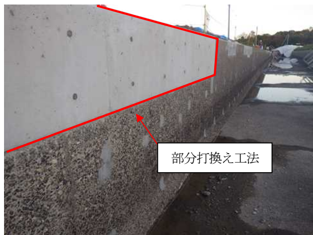
写真-6 部分打換え工法
