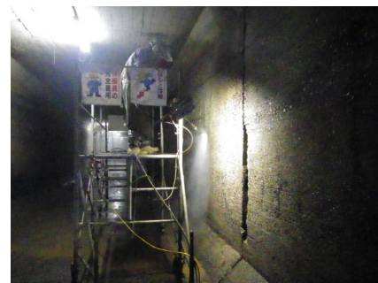
図-15 移動式足場の使用(高圧洗浄工の様子)
