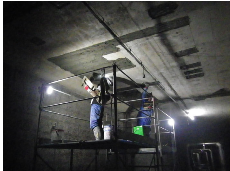
図-16 照明設備(断面修復の様子)
