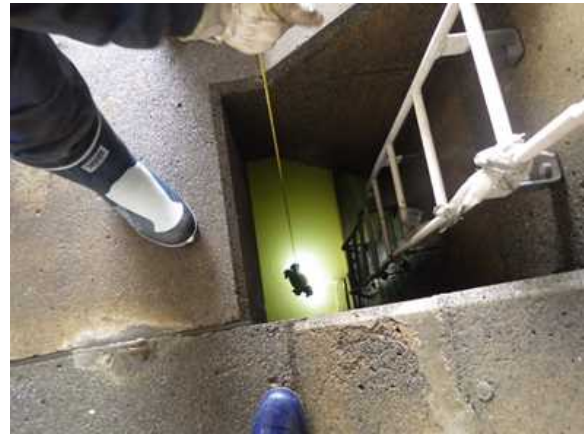
写真-4 水中ドローンによる調査状況写真
