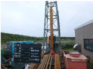
写真-2 対策井戸の掘削状況
