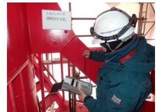
写真-10 調査状況
