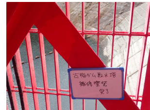
写真-14 塗膜補修後
