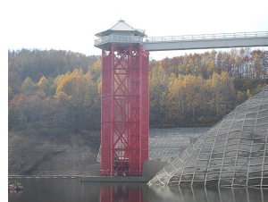
写真-1 取水塔全景
