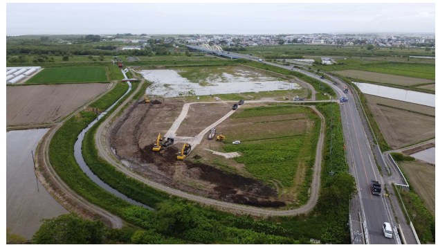
写真-1 遊水地掘削状況
