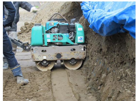
写真-3 鋼土の転圧状況
