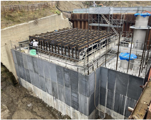
写真-5 コンクリート打設後の状況
