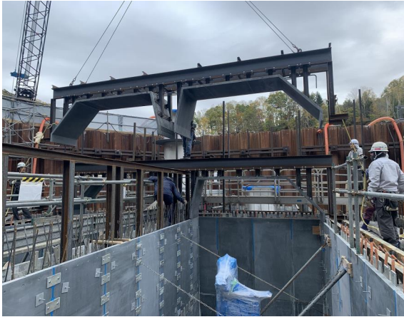
写真-4 プレキャスト型枠の組立状況
