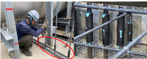
写真-6 作業状況（左側）、作業後（右側）
