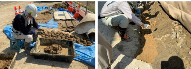
写真-2 コンタクトクレイ施工状況
