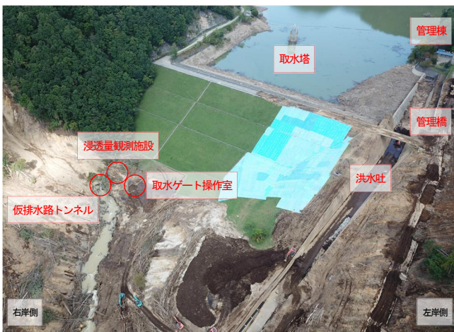
写真-1 厚真ダム被災直後空撮
