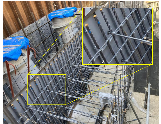
写真-7 機械式鉄筋定着工法の施工状況
