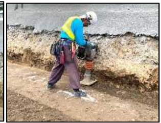
写真-11 振動ローラ(4t級)転圧、ランマー(60kg級)締固め
