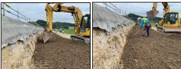
写真-10 バックホウ・人力によるキャタピラ跡の均し
