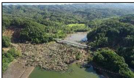
写真-6 ダムの貯水池内への土砂・倒木の流入（写真-5 囲いの状況）
