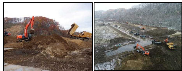
写真-13 土砂の撤去及び運搬
