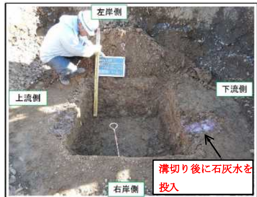
写真-3 No. 22+18断面 全景
