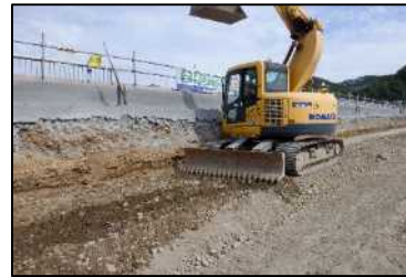
写真-12 バックホウによる掻き起こし
