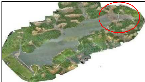
写真-5 ダム貯水池内の土砂崩落（航空写真）
