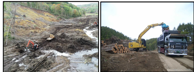
写真-14 倒木の撤去及び運搬
