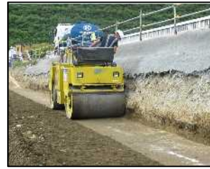
写真-11 振動ローラ(4t級)転圧、ランマー(60kg級)締固め
