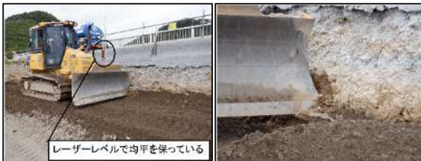
写真-9 ブルドーザによる既設堤体削り取り
