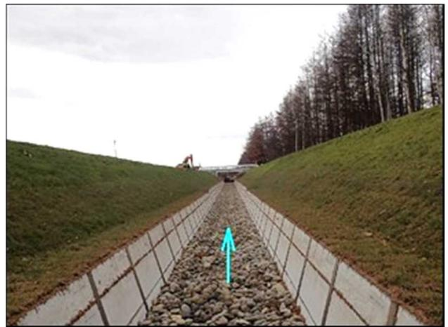
図-10 コンクリート柵渠工区間
