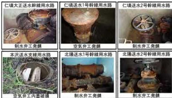
写真-1 弁類の劣化状況
