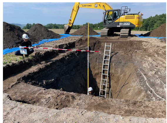
写真4 試掘状況 (大平22工区)
