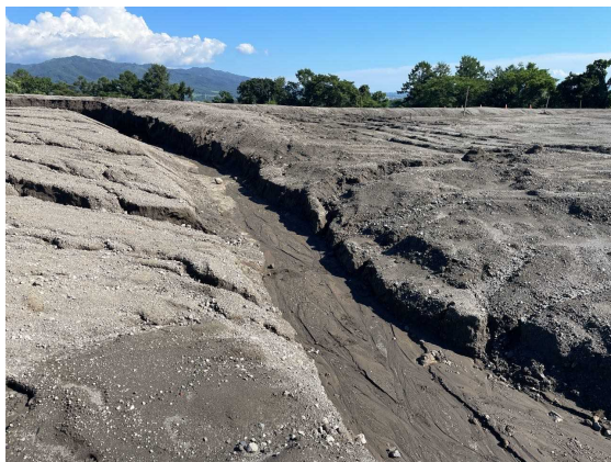
写真3 令和4年8月大雨による浸食状況 (大平22工区)
