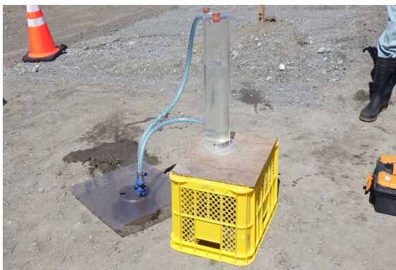
写真-9 現場透水試験(定常法)の実施状況
