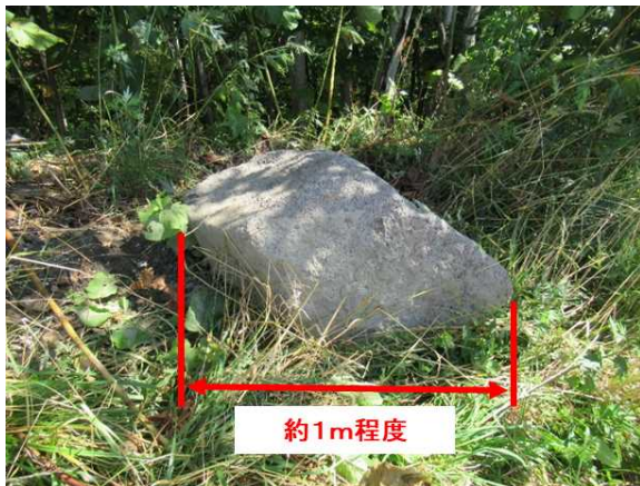
写真-2 巨石の露出
