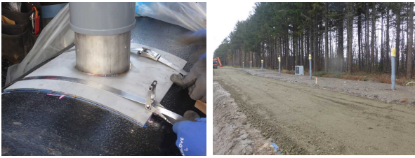
写真-1 設置状況 (①沈下量測定)
