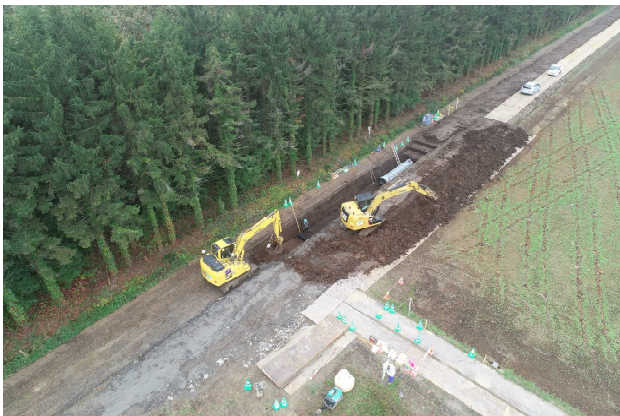
写真-2 管体工・施工状況
