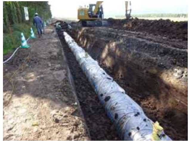
写真-3 管体工・埋戻し状況
