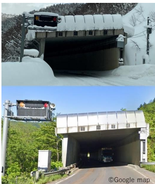
図-1 道路インフラへの着雪：トンネル坑口の例 写真上：冬（櫻井 撮影）、写真下：夏
