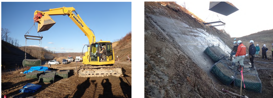
写真-6 ワンパック断熱フトン籠の吊り上げおよびのり面設置の様子
