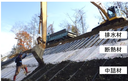
写真-3 断熱特殊ふとんかご施工の様子
