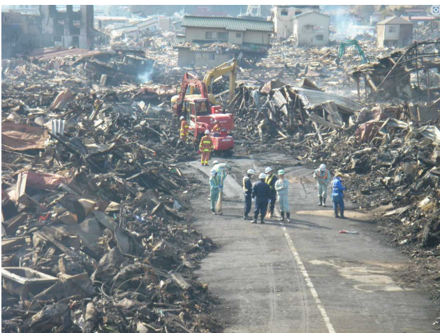
写真-1 道路啓開作業の様子 (東北地方整備局 震災伝承館より) 4)
