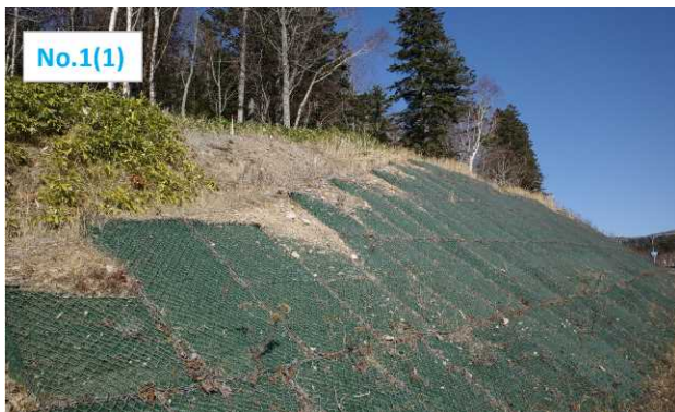
写真-2 No.1(1)特殊布団かご設置状況 (令和4年10月31日撮影)
