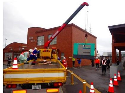
写真-8 発動発電機の設置
