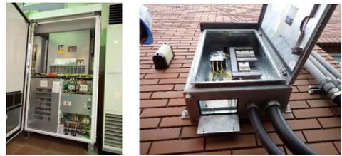
写真-1 無停電化設備 (左：屋内の無停電装置 右：屋外の分電盤) 説明は後述
