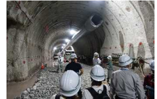
写真-4 現場見学の様子
