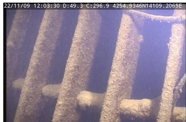
図-7 副ゲート点検架台（水深約14m）
