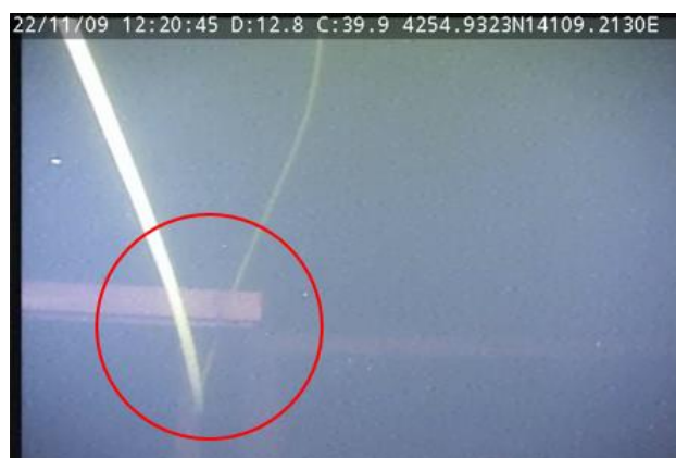
図-10 構造物に引っかかっていたケーブル（水深12.8m）
