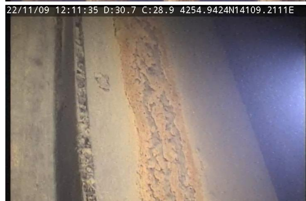
図-8 上段：スクリーン近接撮影（水深49.3 m）、下段：ゲートガイドレール（水深30.7m）
