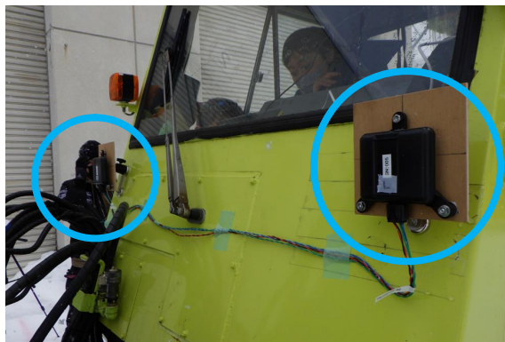
図-2 ミリ波レーダ設置状況
