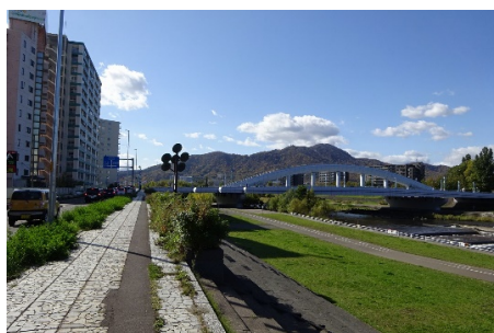
写真-3 堤防上の道路空間
