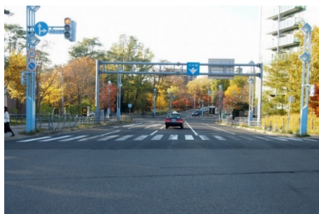
写真-4 地下鉄幌平橋駅側の道路空間
