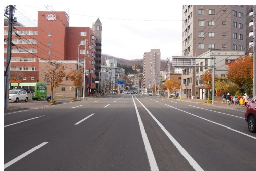
写真-9 環状通の道路空間
