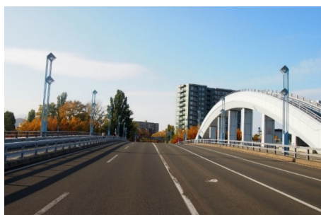
写真-2 橋上空間
