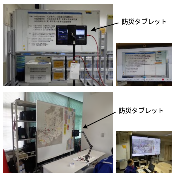
図-13 ホワイトボード・管内図の 防災タブレットによる定点撮影
