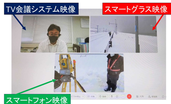
写真-8 庁舎内側検査状況 (道路部門)
