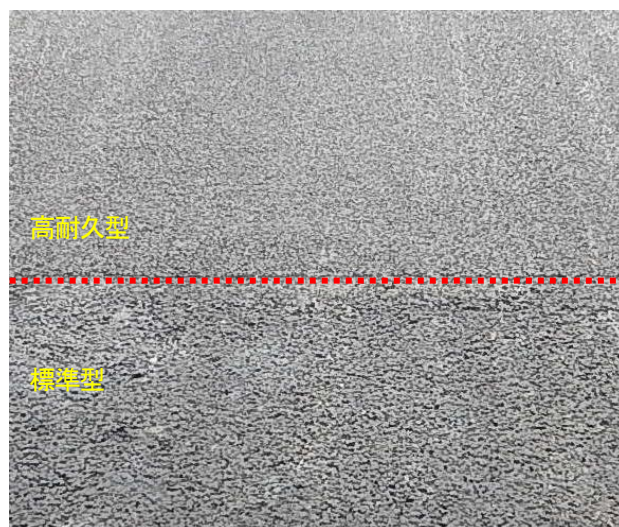
写真-2 舗設後の路面状況(混合物境界部)
