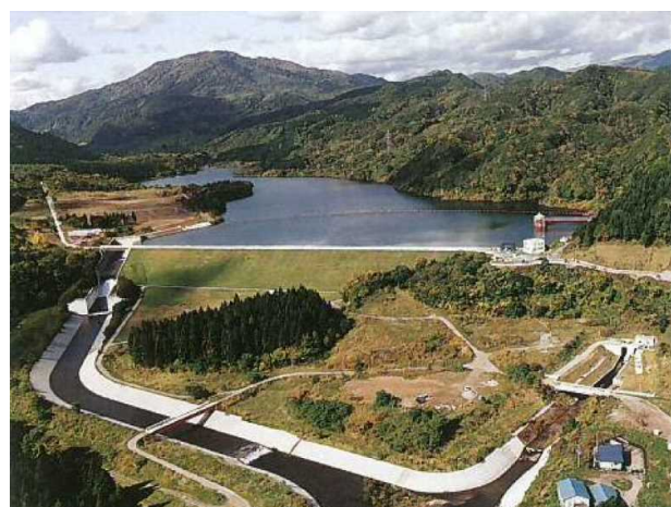
写真-1 上磯ダムの全景
