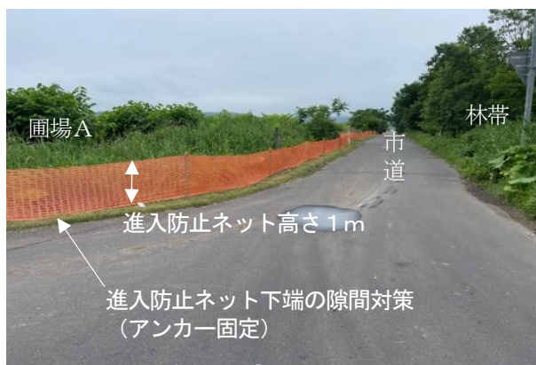
写真-7 進入防止ネットの設置状況
