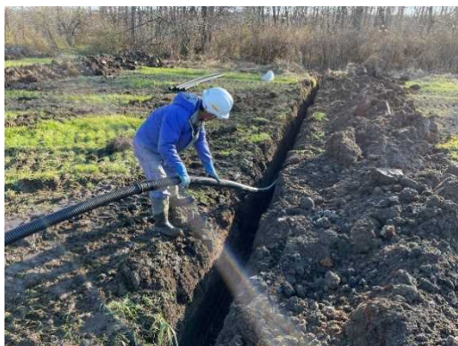
写真-2 暗渠排水工施工状況
