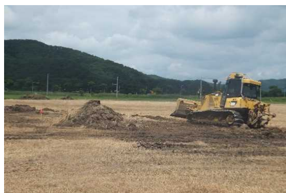
写真-1 整地工施工状況
