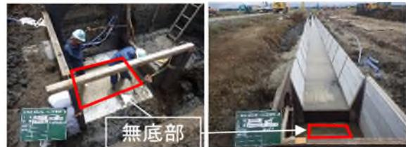
写真-4 深み工（無底樹）施工の様子
