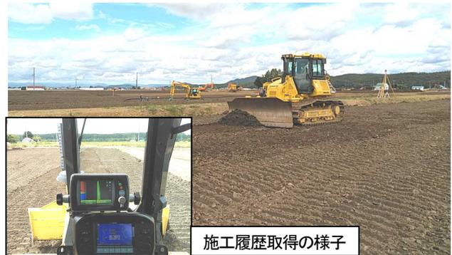
写真3 MC/MGブルドーザによる施工状況
