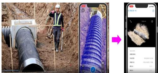
図-8 モバイル端末による測量フロー
