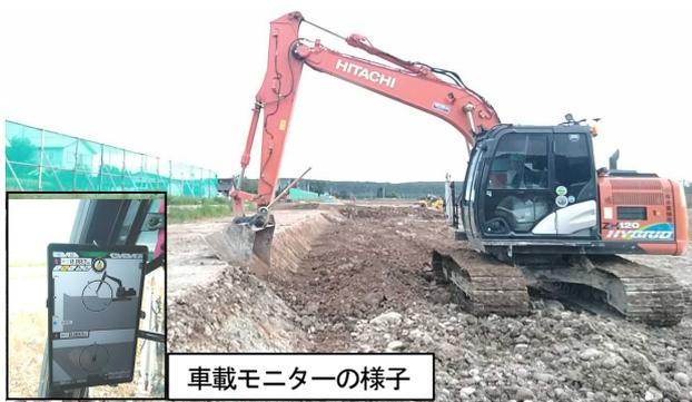
写真-1 ICT建設機械による施工状況
