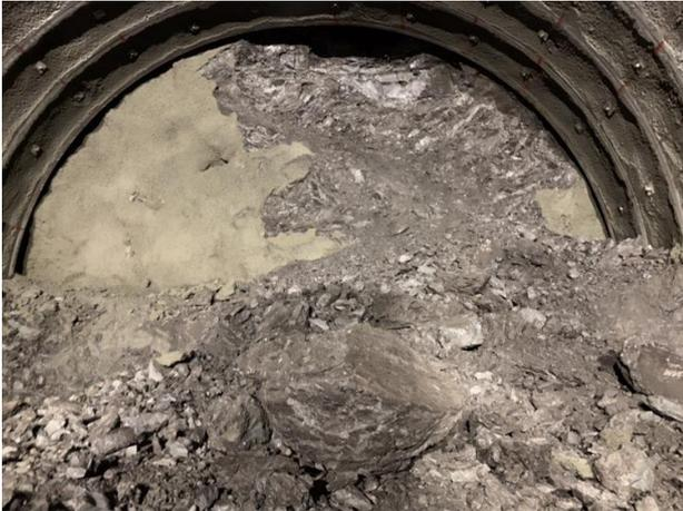
写真-1 鏡面肌落ち状況 (TD=74.0m)
