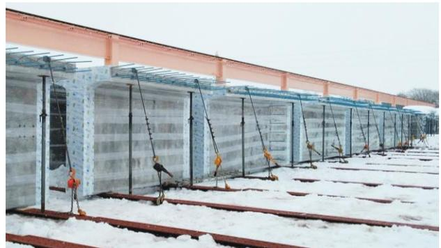
写真-2 継続封緘養生実施状況
