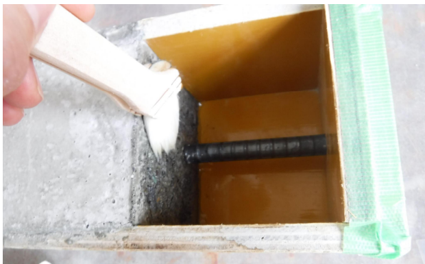
写真-2 既設側の打継ぎ面への表面含浸材の塗布状況
