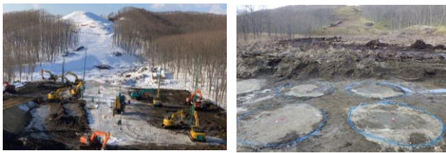
写真-1 地盤改良施工状況(左)と施工後の改良柱体(右)
