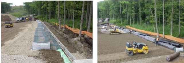
写真-2 のり尻ふとん簀(左)と中詰材の施工状況(右)
