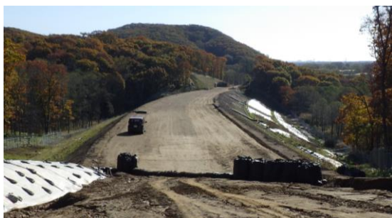
写真-4 盛土施工完了後の全景(起点側より望む)
