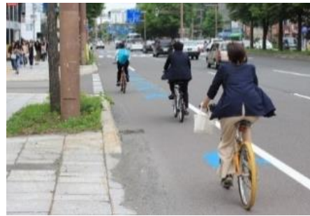
写真-2 矢羽根型路面標示・一般国道 230 号(札幌市)
