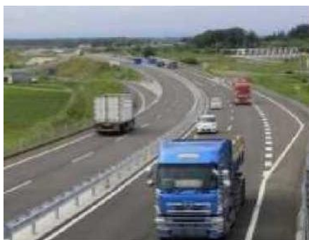
写真-1 道路ネットワーク整備 道央圏連絡道路 泉郷道路
