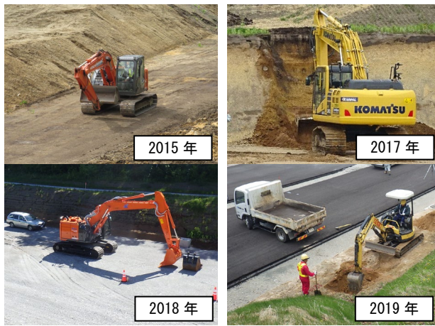
写真-7 工事実施状況
