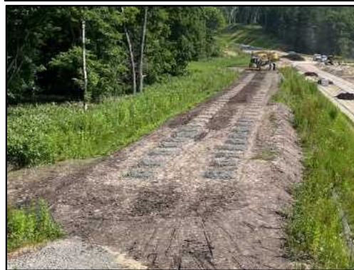
写真-4 防雪林基盤整備状況 （R4撮影、上：暗渠排水管整備状況、下：基盤整備後状況）
